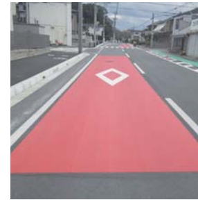
薄層カラー舗装ミストグリップ (溶解噴射式カラー塗装)
