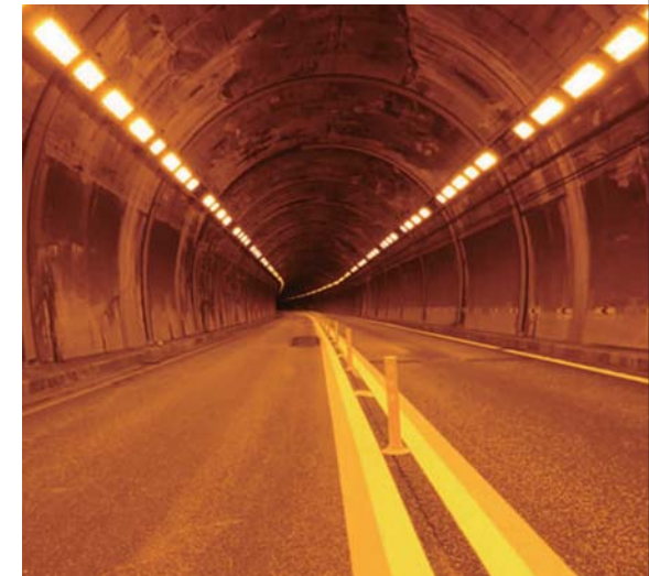
道路錨・車線分離標設置
