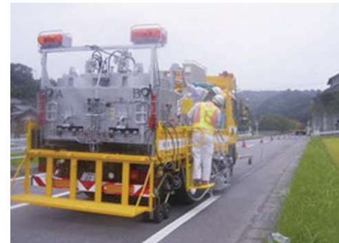
工種/マーカー車施工
