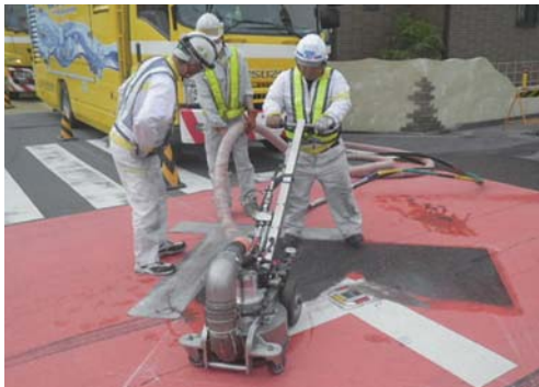
工種/リムーバー施工 その①
