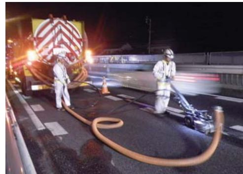
工種/リムーバー施工 その②
